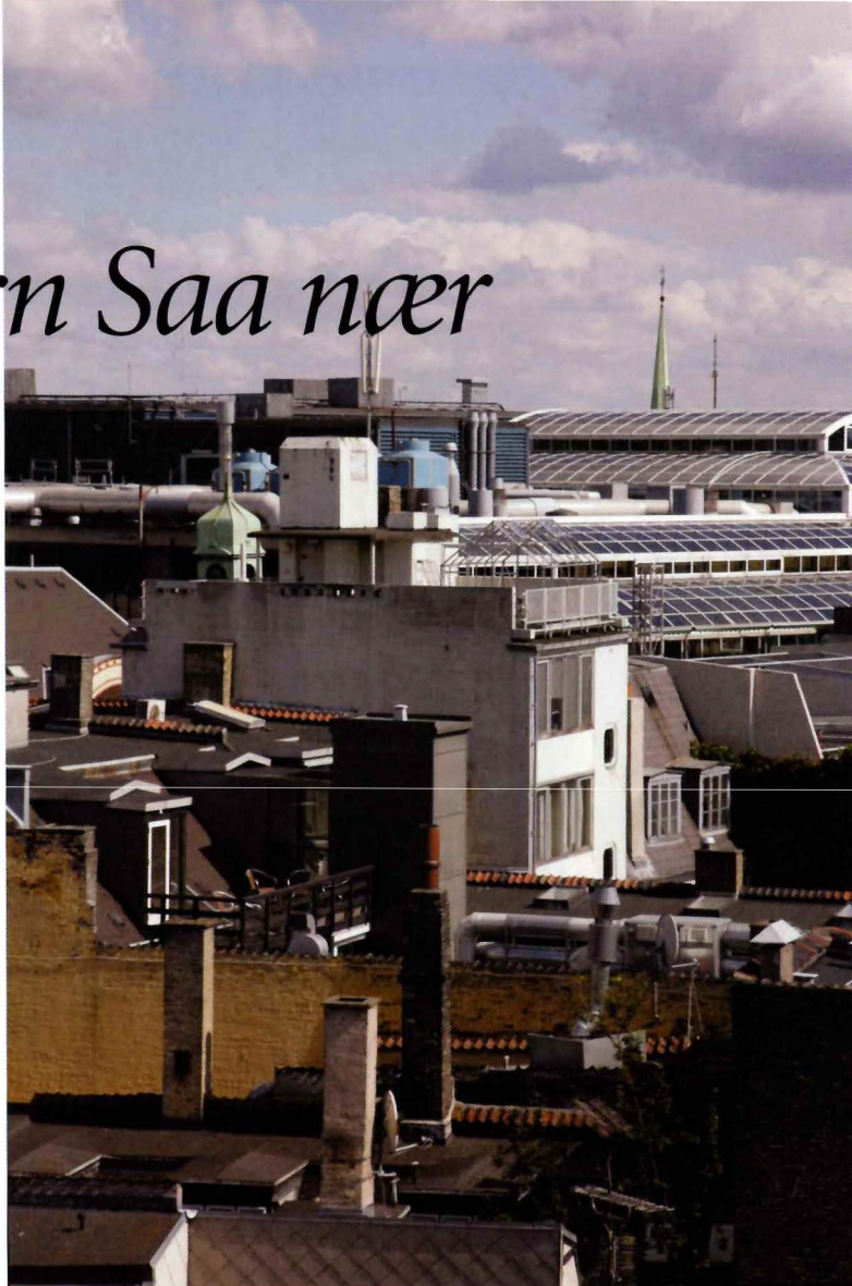
Dette view fra Café Hovedtelegrafens terrasse afslører nogle af de mange master og antenner, der sikrer vor tids behov for kommunikation. Foto: Lasse Ernlund Lorentzen.
