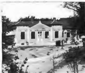
Stationsbygning nr. 2 blev opført i 1869. Postekspeditionen fik lokaler i stationens østre del i 1871.
