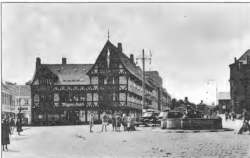
Billede af Wiggers Gaard efter nyopførelsen i 1939. Bygningens historie kan ses i indgangen til Tøjeksperten Palle, idet der øverst på begge sider er anført årstallene samt skitse af bygningen. Årstallene er 1855 – 1888 – 1906 – 1939. I forgrunden ses "Havfruespringvandet".
