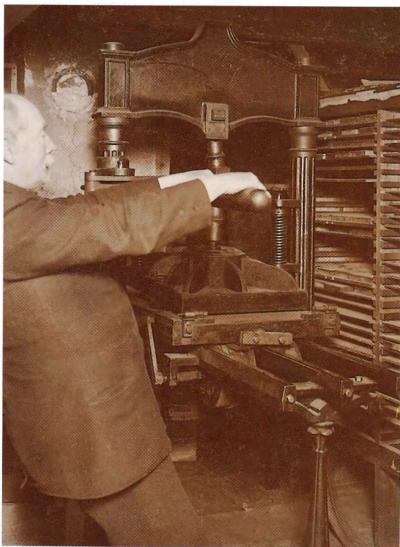
Demonstration af frimærketrykning i København i 1890'erne. Maskinen er den, der blev anvendt til trykningen af Danmarks første frimærker i 1851. Desværre er den ikke bevaret, men museet har lånt en tilsvarende trykpresse på Danmarks Grafiske Museum i Odense, og den er allerede opstillet i museets foyer som blikfang for udstillingen „Min Skat“.
