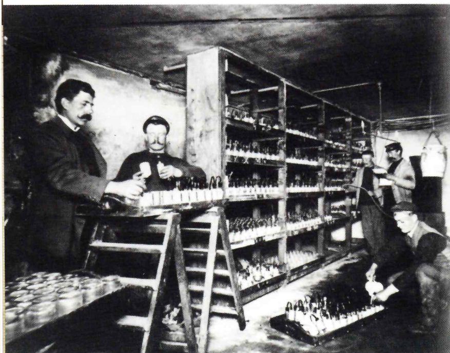
Batterikælder under Hovedtelegraf. København, o. 1895
