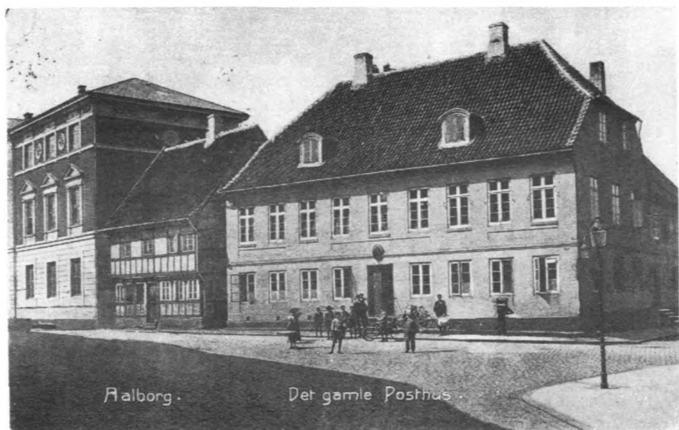
Den grundmurede bygning var Aalborgs posthus fra 1847 til 1908. Bindingsværkshuset er genrejst i Niels Ebbesens Gade og kaldes fejlagtig Det gamle Posthus .
